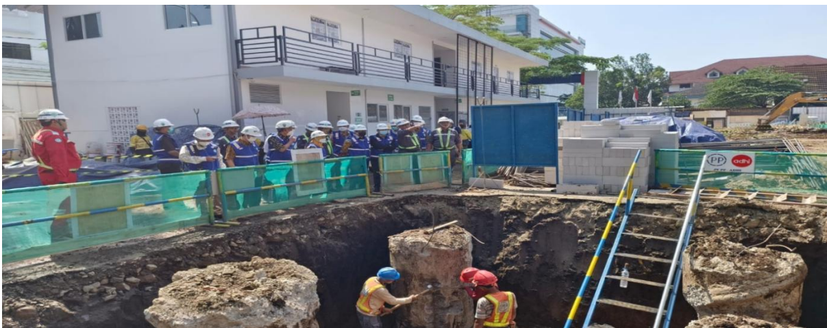
Gambar 6.5 Kunjungan RSUD Undata Provinsi Sulawesi Tengah sebagai RS Rujukan Sulawesi Tengah untuk Layanan Kanker ke RSHS. Melakukan kunjungan ttg Pembangunan Bungker dan Pelayanan Radioterapi yang ada di RSHS sekaligus penandatanganan MOU Pengampuhan Kanker yang direncanakan besok (MOU di hari Jumat), 19-20 Januari 2023
